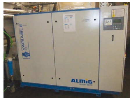
Bei Langguth Erben kommen jetzt zwei Schraubenkompressoren der Baureihe VARIABLE 55 zum Einsatz
